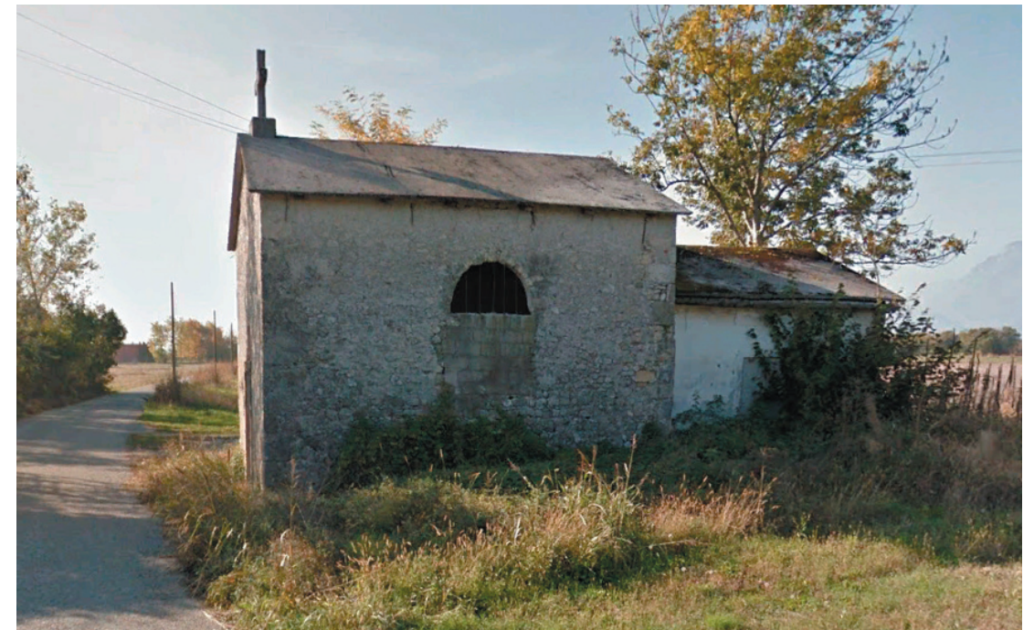
La Chiesa sconsacrata di San Urbano a Sequals, vista da est.
