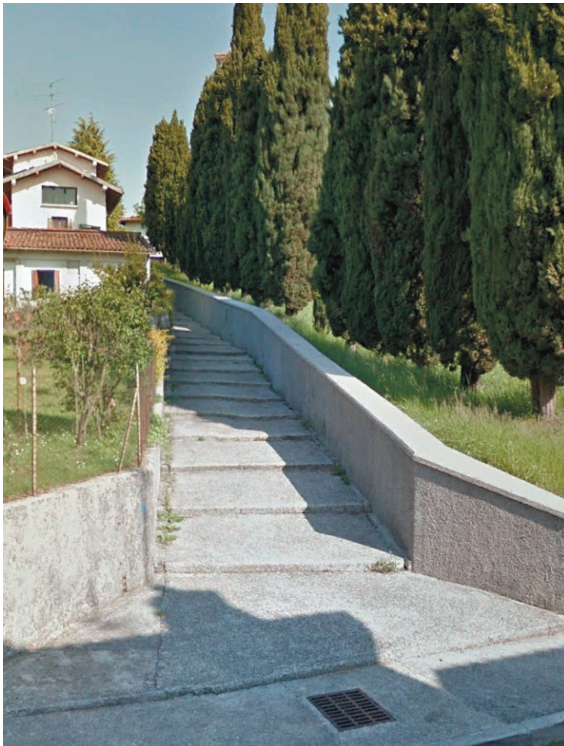
La scala con gradini a passo lungo della Chiesa di Lestans. Qui aveva termine il lungo sentiero tra Enemonzo e la pianura concordiese che percorreva la Val d'Arzino e la val Cosa. Qui aveva termine la via Giulia o litoranea destra del Tagliamento che partiva da Concordia. Qui aveva termine il lungo rettilineo della via Pinzana che partiva dal ponte in pietra sul Livenza di Cavolano, diretta al guado di Pinzano e Ragogna.
